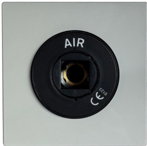
Druckluftentnahmedose med. Druckluft ( 5bar ) für Druckluftreinigungspistole**
