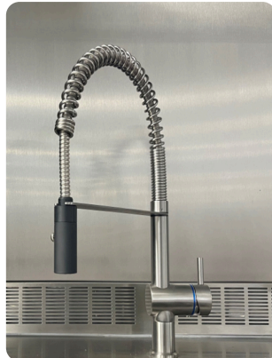
Reinigungsbrause Warmwasser/ Kaltwasser unter der Schutzhaube montiert
